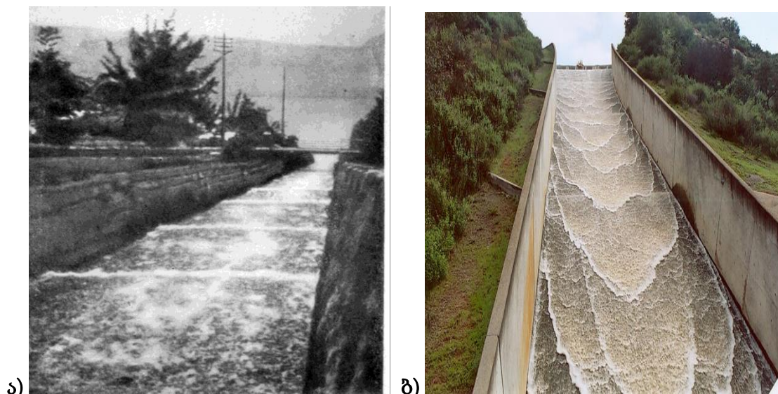
ნახ. 5.5. ბორის ტიპის მგორავი ტალღები სწრაფდენებზე. ა) ბორის ტიპის პერიოდული ტალღები შვეიცარიის ერთ-ერთ სწრაფდენზე (სტოკერი, ნახ.11.3.4); ბ) მგორავი ტალღები აშშ-ს ერთ-ერთი ჰიდროკვანძის წყალსაგდებში (პონსე, ნახ.5)
