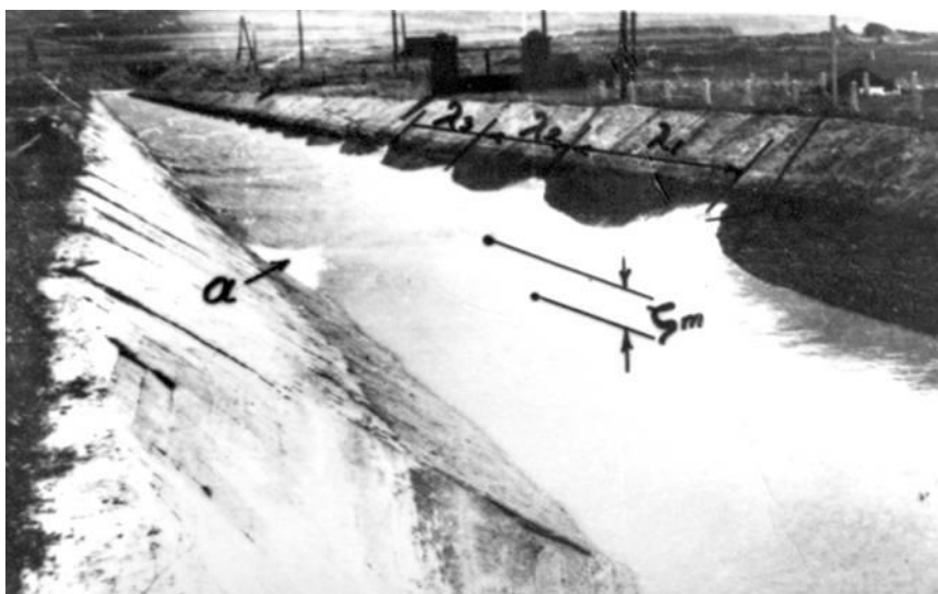
ნახ. 4.2. ნაპირგასწვრივი ტალღები ჰიდროელექტროსადგურის გამყვან არხში (ჩრდ. კავკასია, ტურსუნოვის ფოტო)
