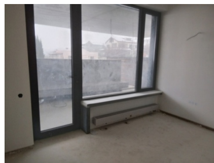
ნახ.8 შემინული ზედაპირების ჭავლური თბური დაცვა: ა-იატაკქვეშა არხული კონვექტორით ბ- დაბალი კონვექტორებით
