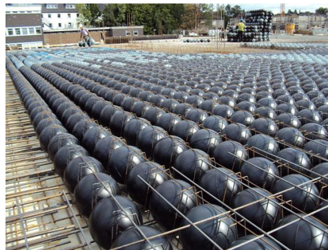
სურ. 25. რკინაბეტონის მონოლითური მოედნის მოწყობა კობიაქსის სისტემის გამოყენებით
