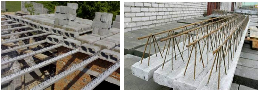
სურ. 6. ანაკრებ-მონოლითური კომბინირებული გადახურვა
