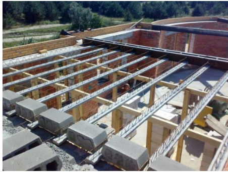
სურ. 7. ანაკრებ-მონოლითური კომბინირებული გადახურვა ფოლადის კოჭებით
