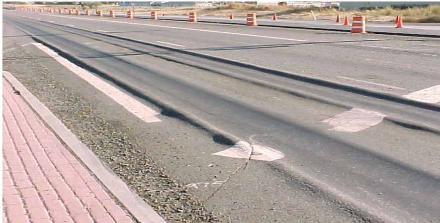
ნახაზი 22. საავტომობილო გზაზე გაჩენილი ე.წ. “ნაკვალევები“
