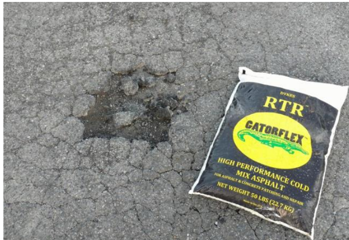
ნახაზი 2. დასაწყობებული ცივი ა/ბეტონის ნარევი ორმოული შეკეთებისათვის.
