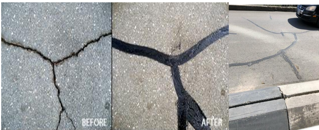
ნახაზი 8. ა/ბეტონის დაზიანებული საფარი შეკეთებამდე და შეკეთების შემდგომ
