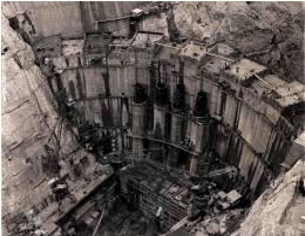
ფოტო 1. ჩირგვი ჰესის თაღოვანი კაშხალის მშენებლობა. ბეტონირებადი ბლოკები.
